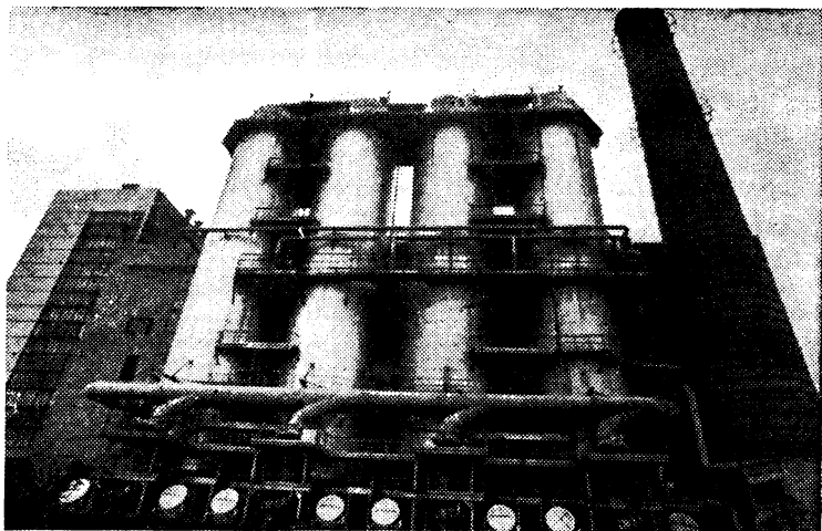
Рис. 72. Первая в мире советская МГД-электростанция (вид со стороны камер сгорания).
